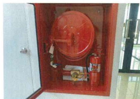
ตู้ FHC และป้ายแสดงวิธีการใช้อุปกรณ์
