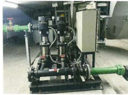
ระบบสูบน้ำใช้ในอาคาร
