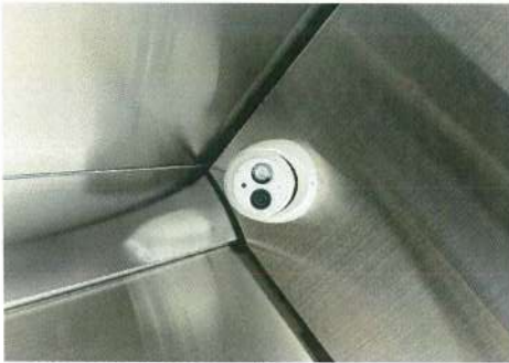
รูปที่ 2.16 ระบบกล้องวงจรปิดภายในของโครงการ
